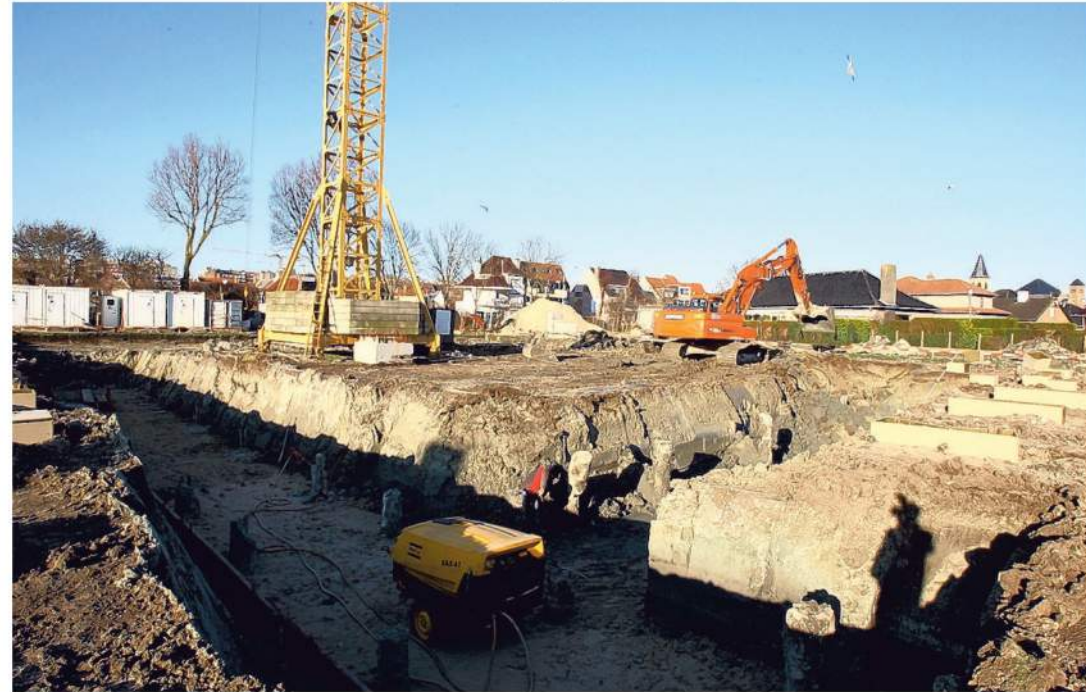
In de Westendelaan is de voorbereiding van de bouw intussen aan de gang. Foto Benny Proot
